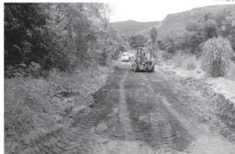
Os trabalhos abrangem quatro metros de alargamento em 18 km de extensão
